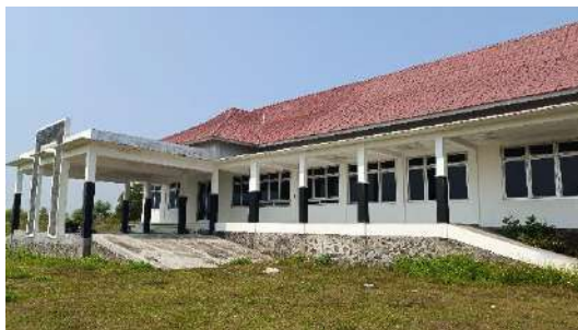
Gambar 3.5 Kantor Operasional Pelabuhan Niaga
