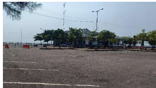
Gambar 3.6 Kantor Operasional Pelabuhan Penyeberangan
